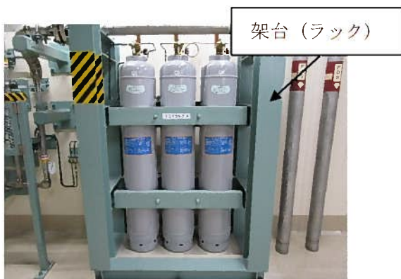
ハロン 1301 (1号原子炉補助建屋)
