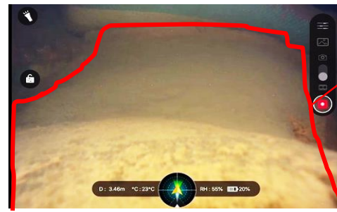
11m付近ROVからの土嚢画像
