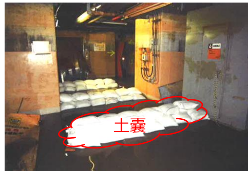
②HTIの土嚢設置時の状態
