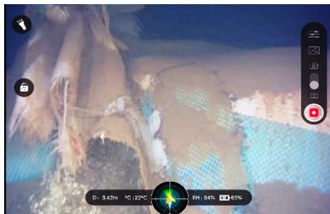
破損している土嚢
