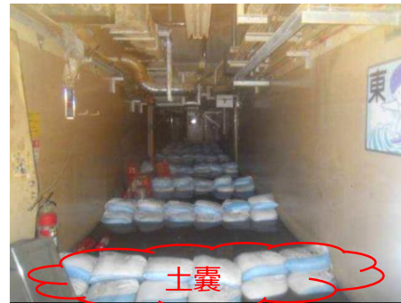
①PMBの土嚢設置時の状態
