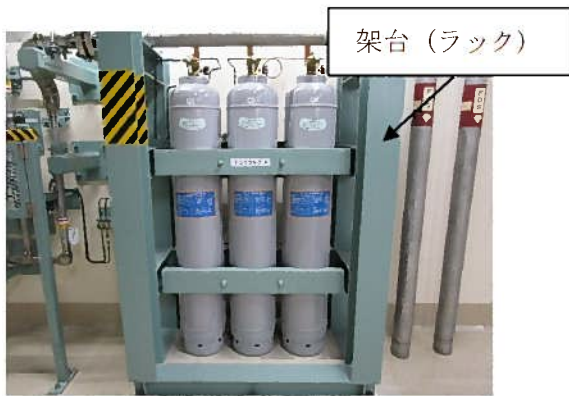
ハロン 1301 (1号原子炉補助建屋)
