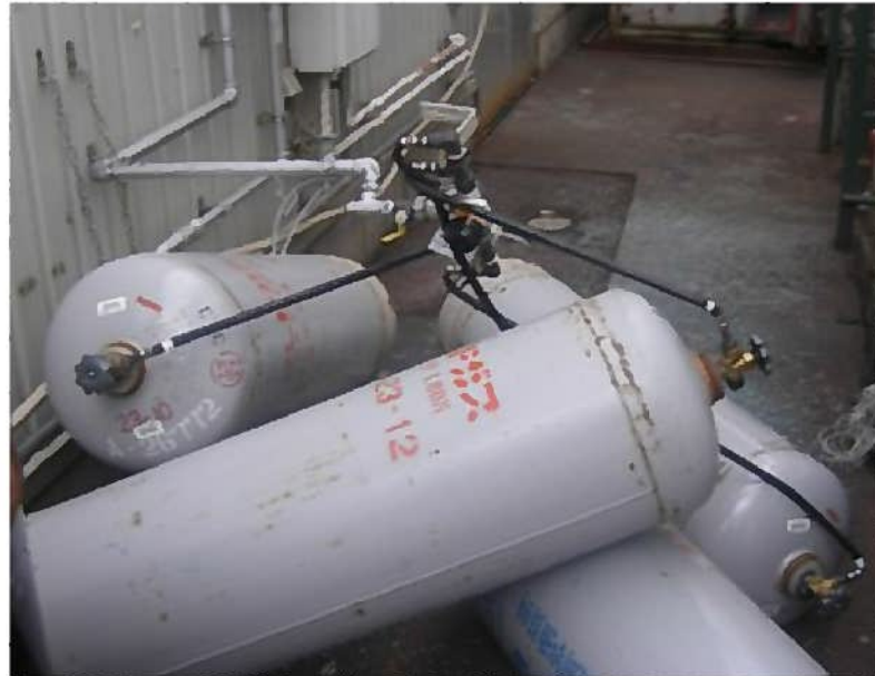
東日本大震災でのLPガスボンベの被災状況の一例 3)
