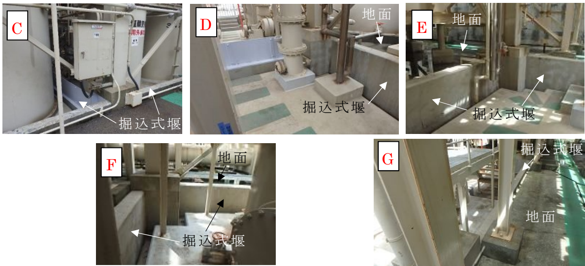
図 5 堰周りの状況 (A - 構内排水処理装置 塩酸貯槽)
