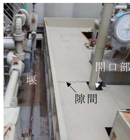
図1 高浜発電所 4号炉 タンク堰への覆い設置状況
