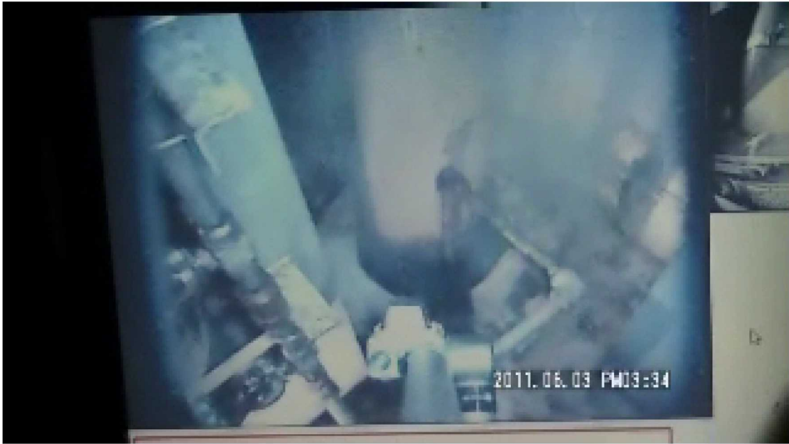
別図2 1号機 R/B1 階床貫通部からの蒸気放出（平成23年6月3日撮影）
