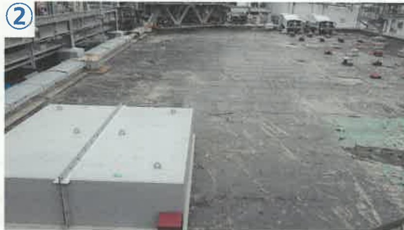
② 撤去後状況
