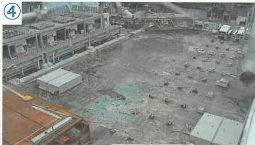
④ 撤去後状況
