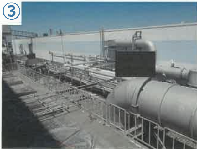
③ 撤去前状況
