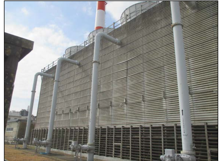
冷却塔倒壊前(H30.2.16撮影)
