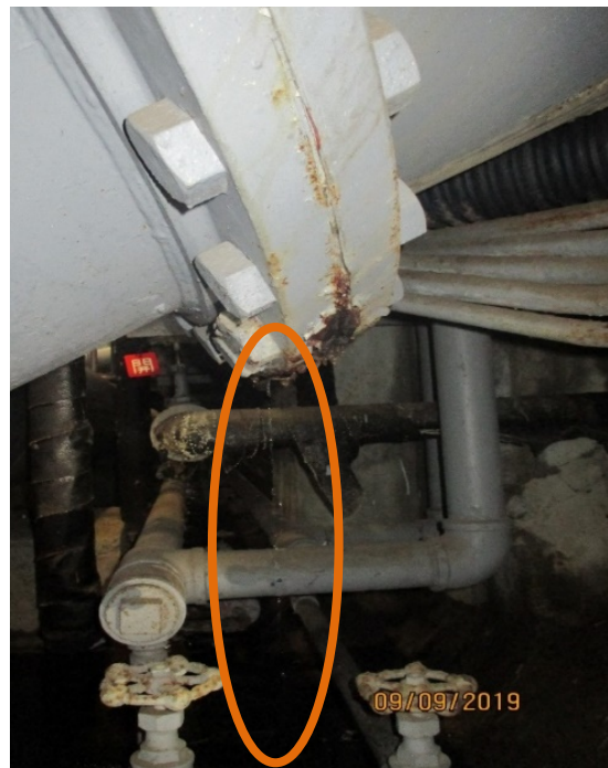
二次冷却系配管 止水前
