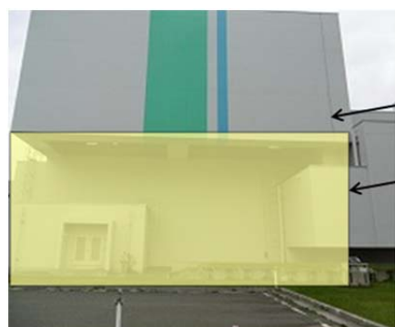
外気取入部への除灰用ろ布設置イメージ
