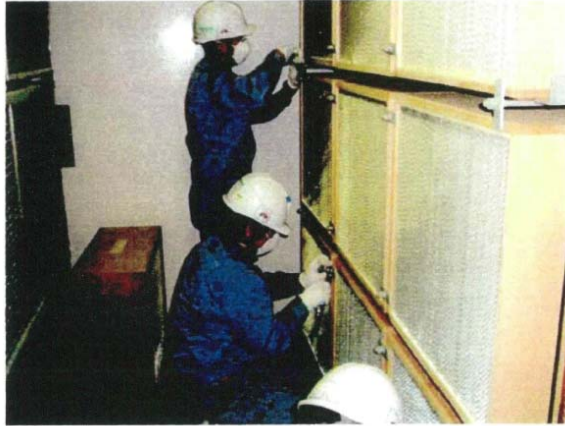
ボルトの取り外し及び取り付け作業状況
