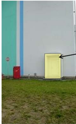
外気取入口(扉)への除灰用ろ布設置イメージ
