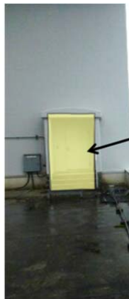
外気取入部への除灰用ろ布設置イメージ
