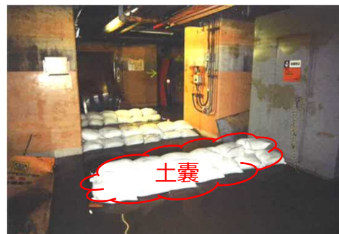
②HTIの土嚢設置時の状態
