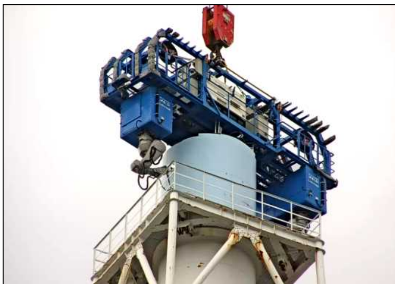
【写真⑤】 切断状況(10月8日)
