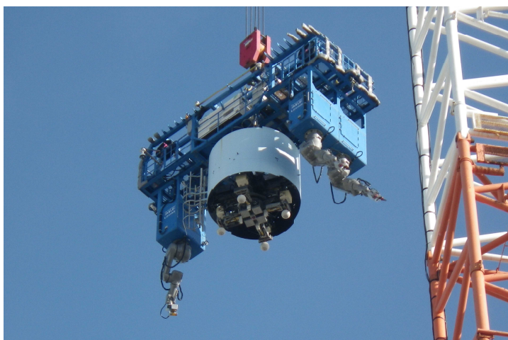
【写真③】吊り下ろし状況(9月26日)
