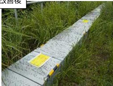
高圧ケーブル (トラフ化・防護板設置)
