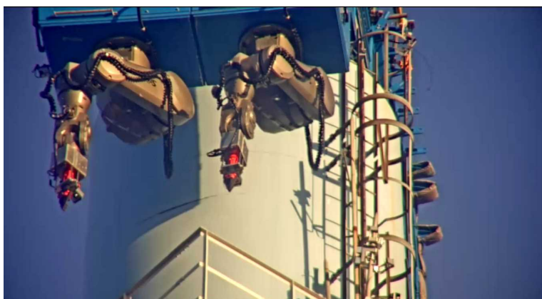
【写真①】筒身切断状況(9月18日)
