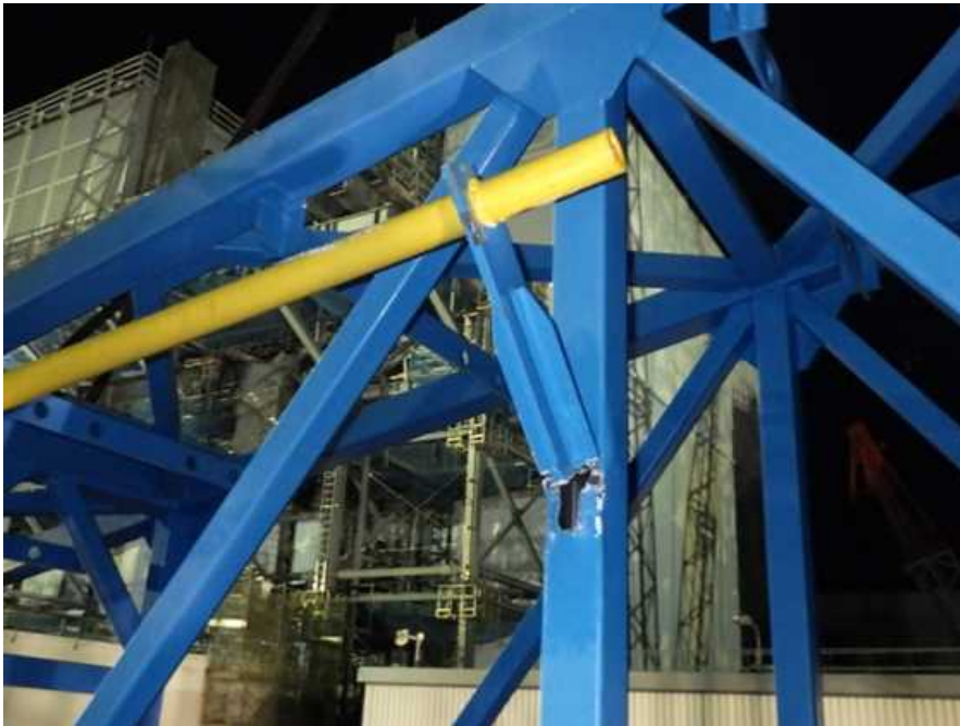
【鉄塔解体装置フレーム状況】
