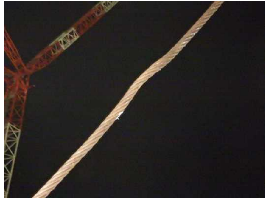
【鉄塔解体装置吊りワイヤー状況】
