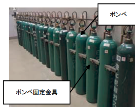
【3号炉タービン建屋 (発電機ポンベ庫)】
