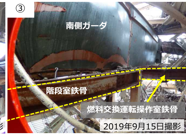
2019年9月15日撮影 南側ガーダの接触状況
