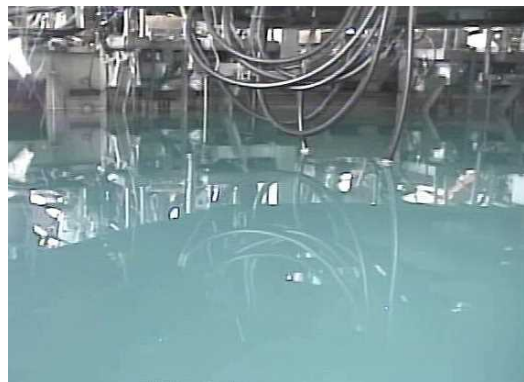
水面上の状況 (調査2) (撮影日2019年9月4日、水面上)
