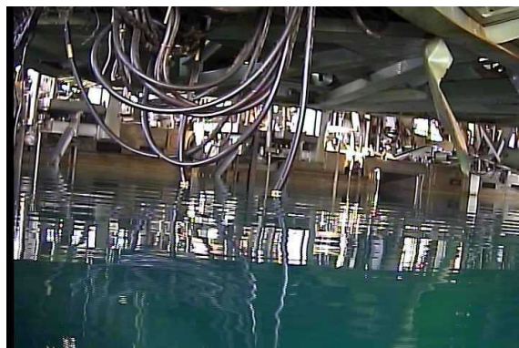
水面上の状況 (調査1) (撮影日2019年8月2日、水面上)
