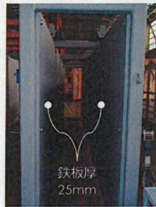
衝立形状③ (鉛板取付前)
