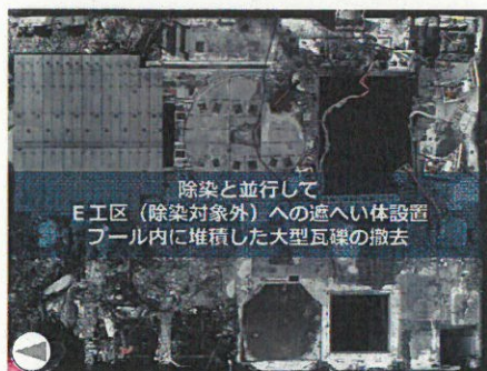
除染・遮へい体設置・プール内大型瓦礫撤去 並行実施 (撮影日2015年11月3日)
