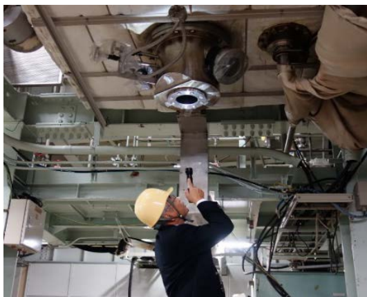
担当理事によるモックアップ試験棟のコールト試験溶融炉の確認
