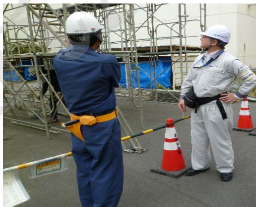
センター長の現場巡視(窓ガラスの交換:許認可工事)
