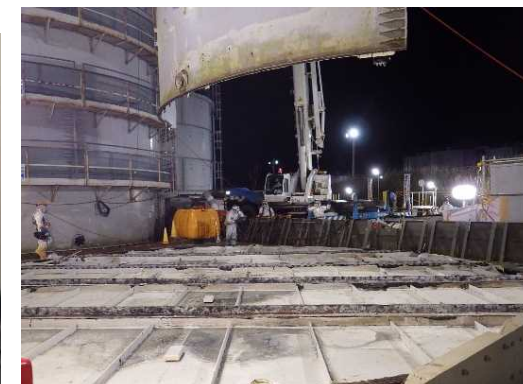
【1段目撤去状況】 1段目・底板を撤去
