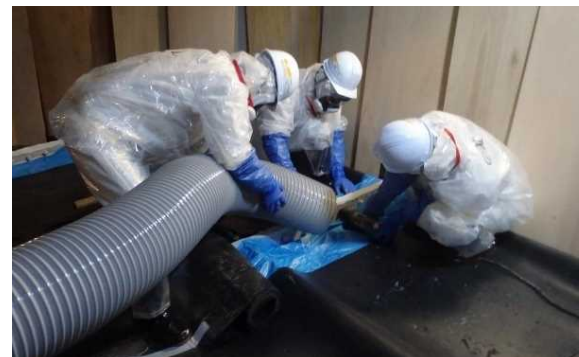
【ボルト間引き状況】 底板のボルトを間引き・撤去
