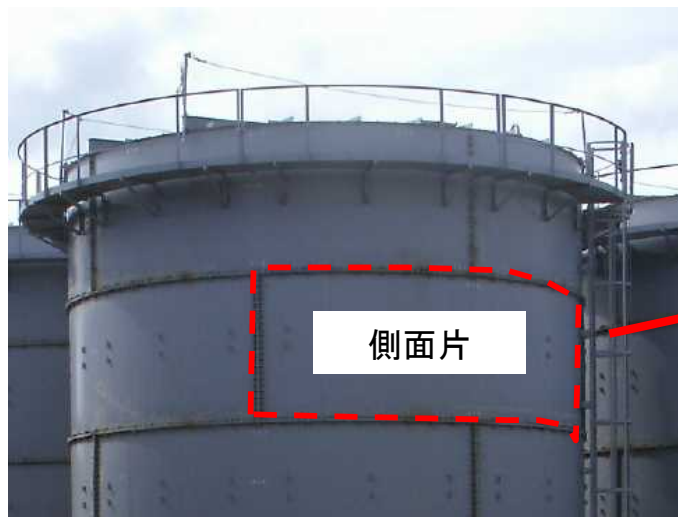
鋼製円筒形フランジ接合タンク
