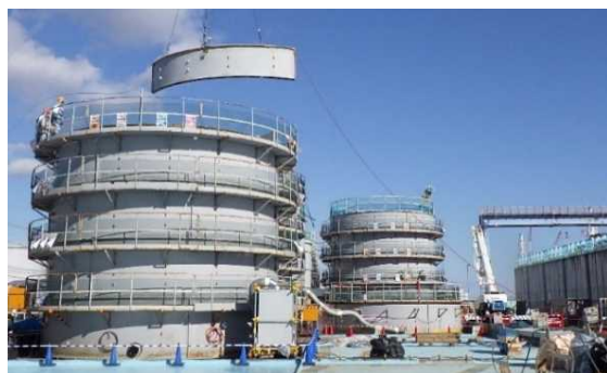
【4段目撤去状況】 天板～2段目を撤去
