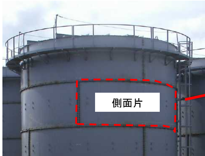
鋼製円筒形フランジ接合タンク
