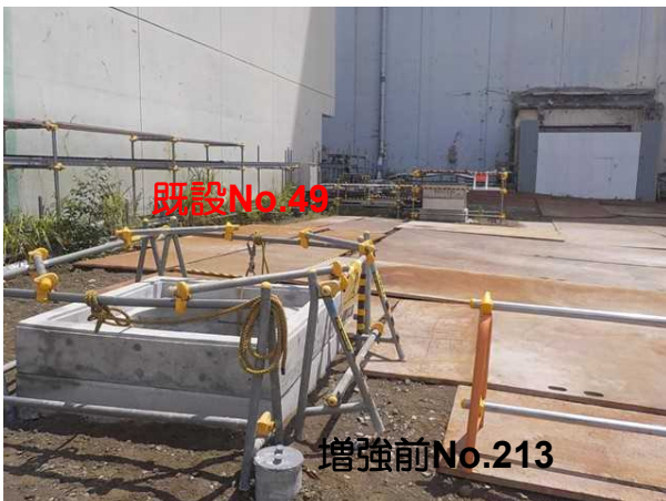
No.49ピット周辺
