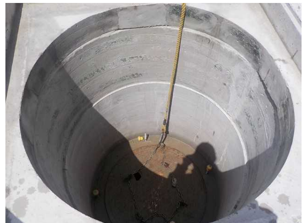
No.49ピット内部
