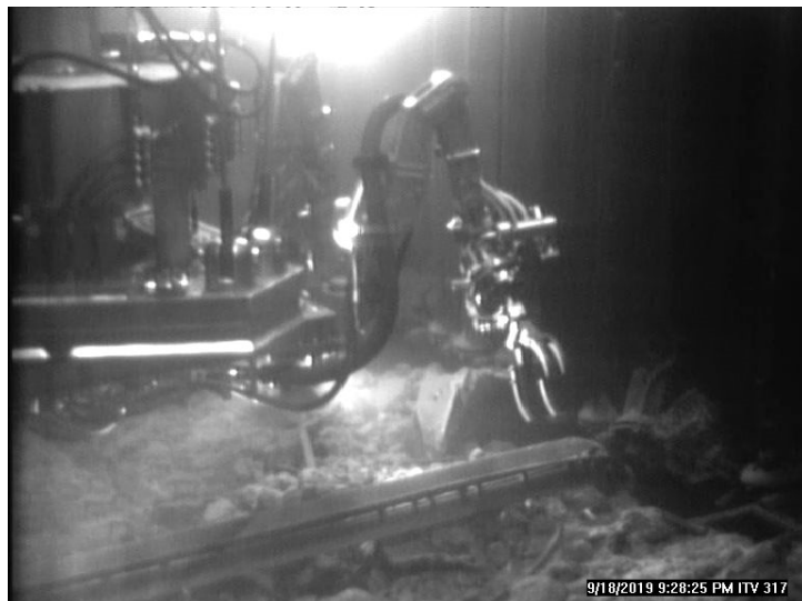
下端（落下速度リミッタ部）を把持しマニピュレータの旋回操作で移動(2019/9/18撮影)
