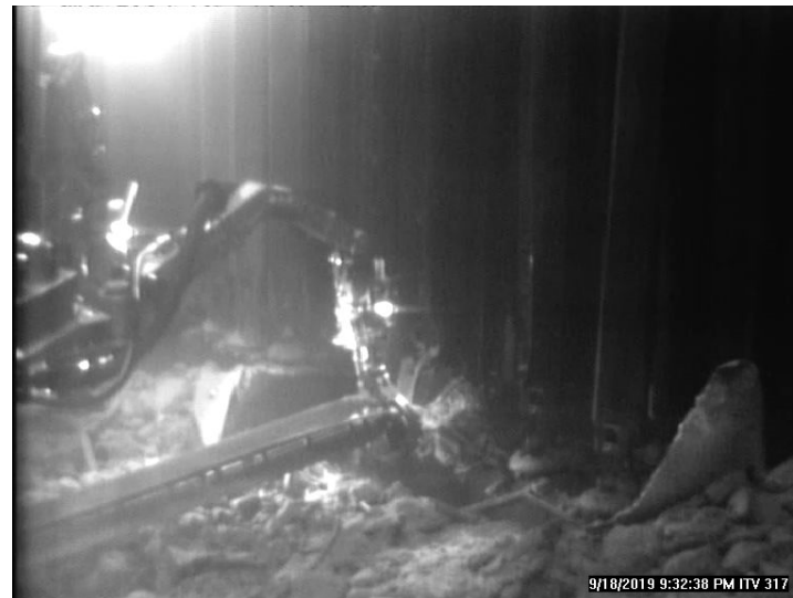
下端（落下速度リミッタ部）を把持しマニピュレータの旋回操作で移動(2019/9/18撮影)
