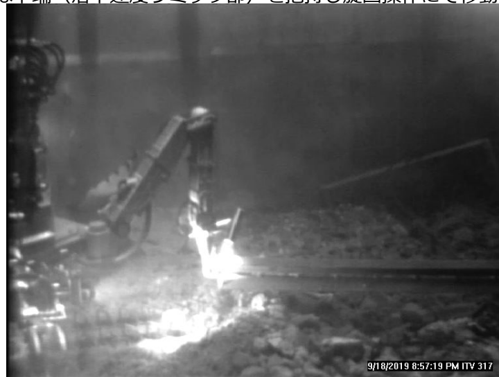
上端（ハンドル部）を把持しマニピュレータの旋回操作で移動(2019/9/18撮影)
