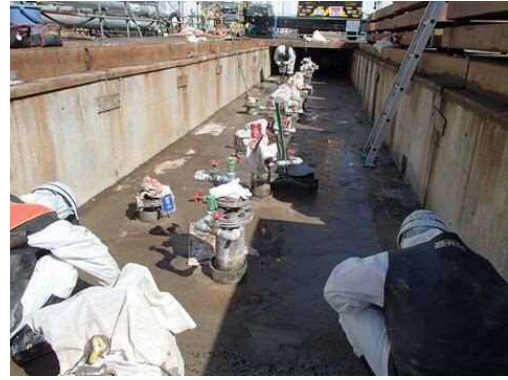
トレンチ設置完了
