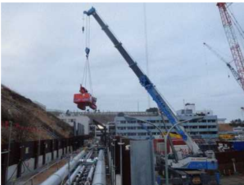
削孔機搬出
