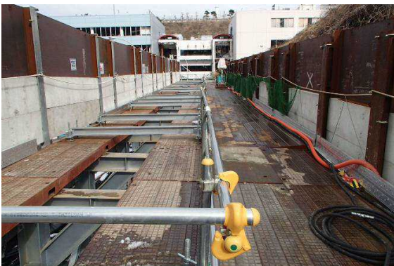
配管架台設置
