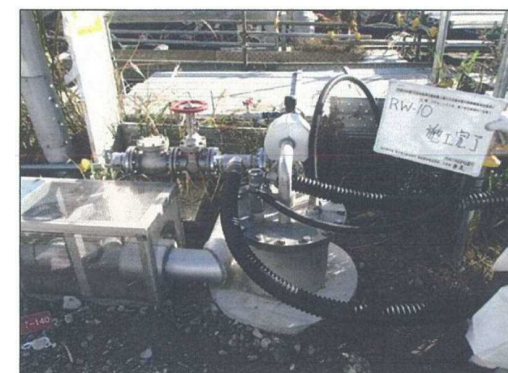
リチャージウェル設置状況 (近景)
