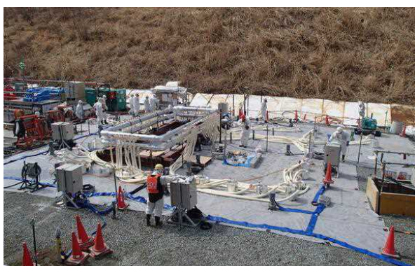
小規模凍土ヤード凍結開始時全景
