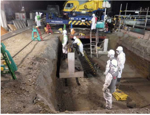
トレンチ設置
