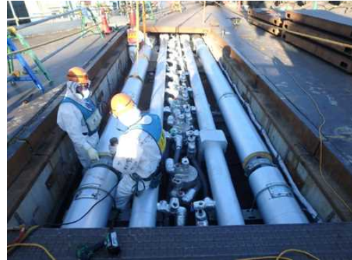
ブライン配管設置
