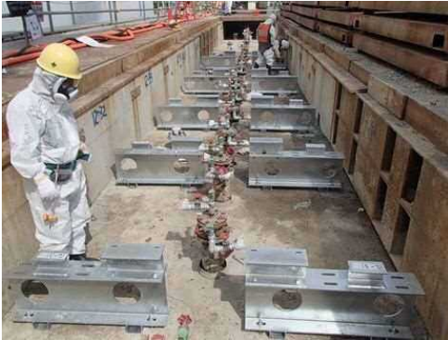
配管架台設置
