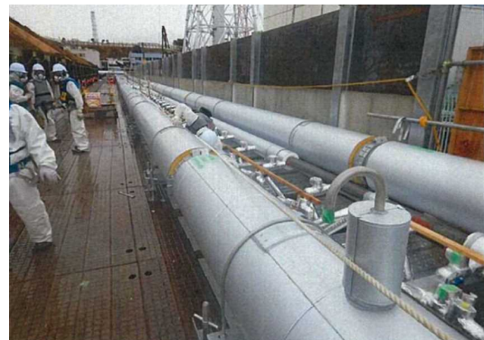
ブライン配管設置
