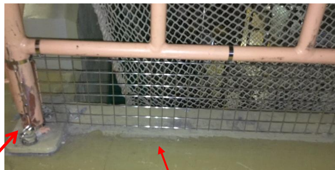
トウプレート部は溢水が流れやすいように加工
