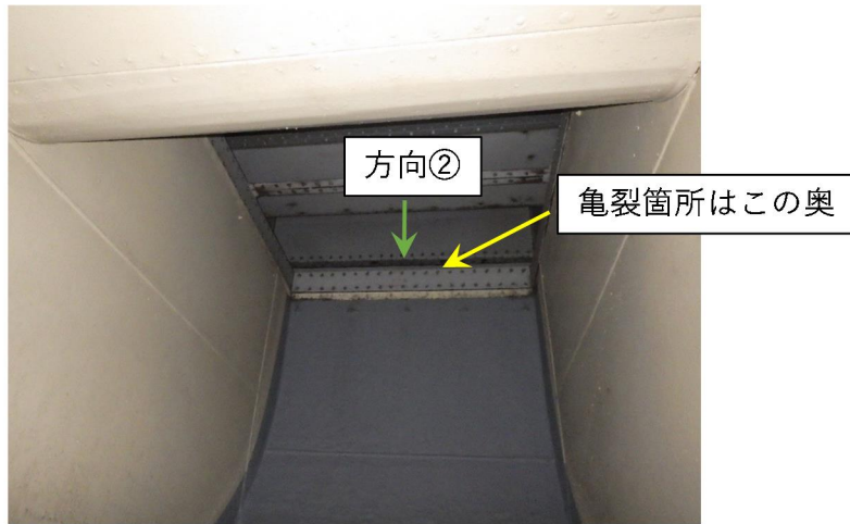
写真4 ダクト内部（下から見たとき）
