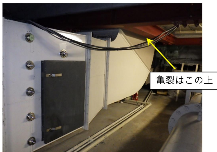
写真3 ダクト部分（下から）
