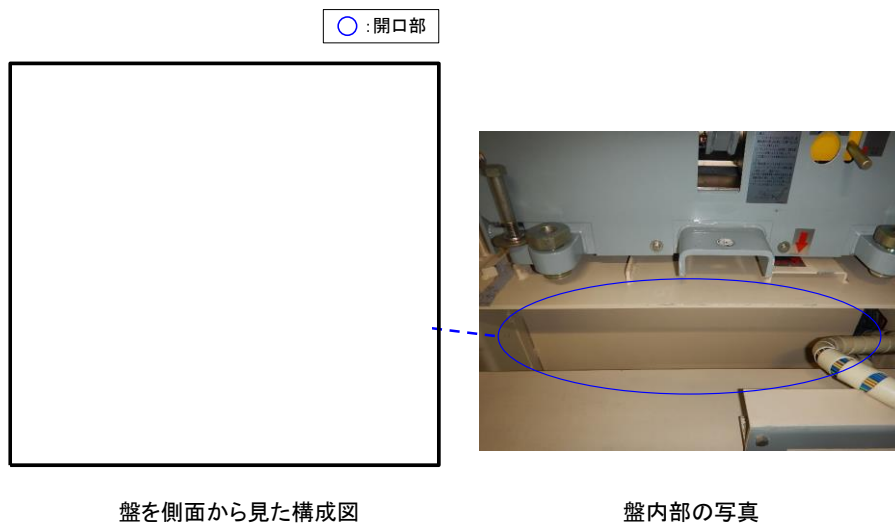
図1 実機の電気盤の開口部 (M/C)
