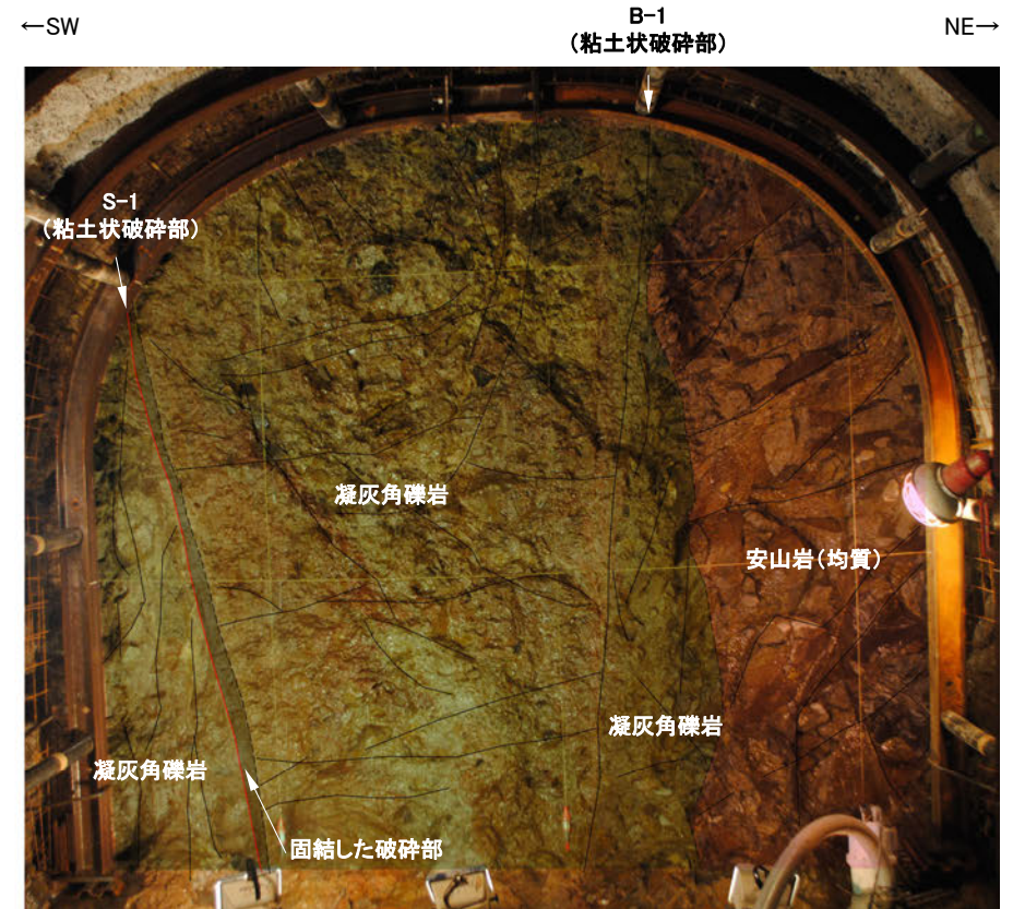
No.26切羽写真(割れ目等を加筆)
