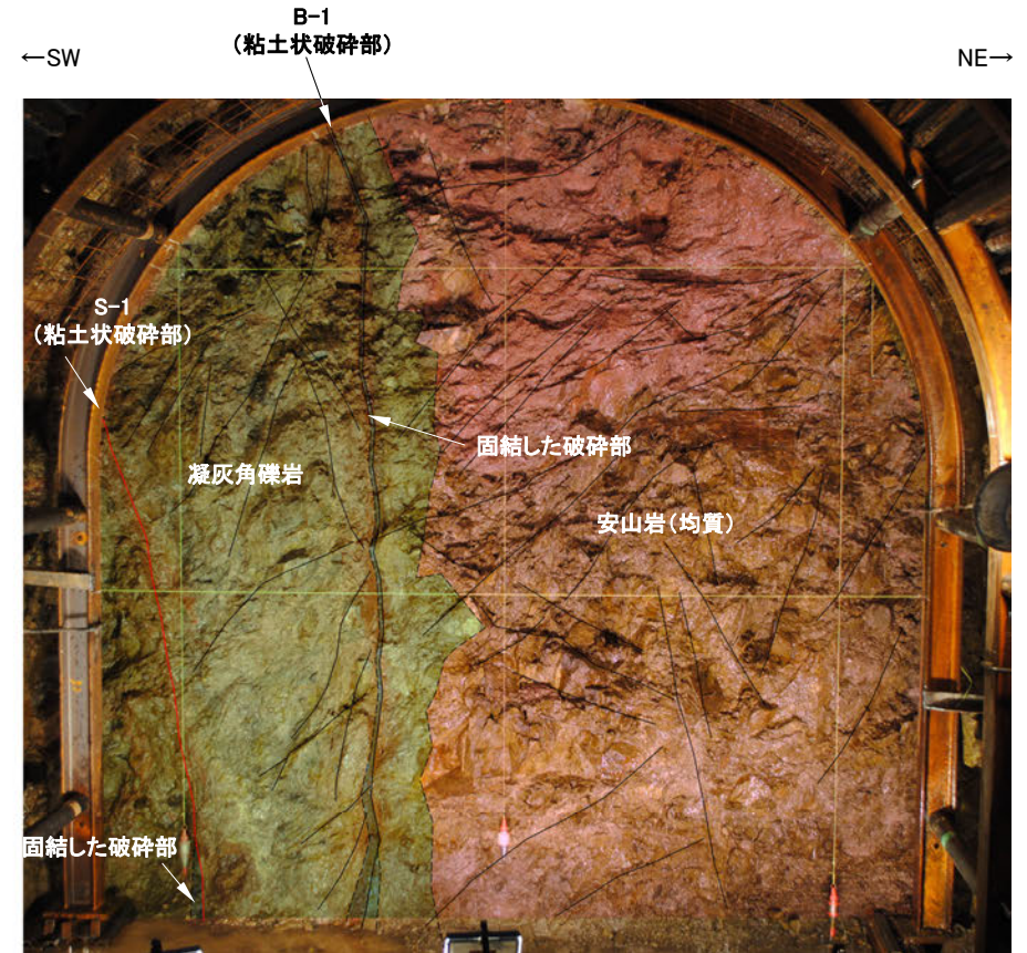
No.5切羽写真(割れ目等を加筆)
