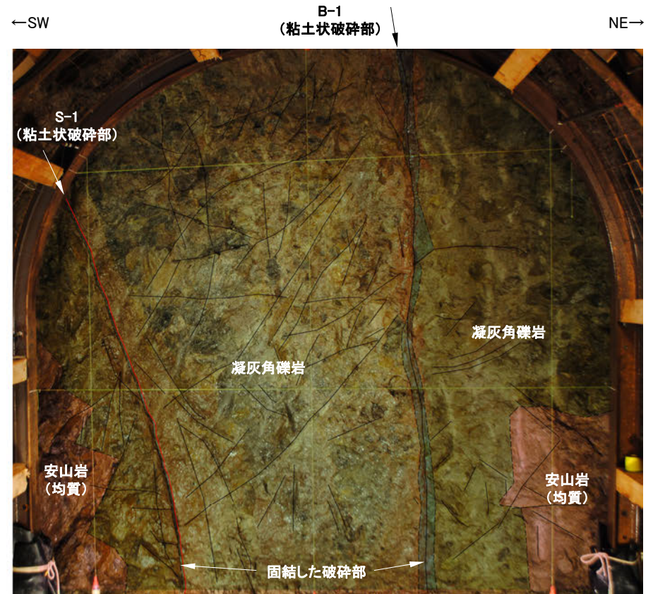
No.11切羽写真(割れ目等を加筆)
