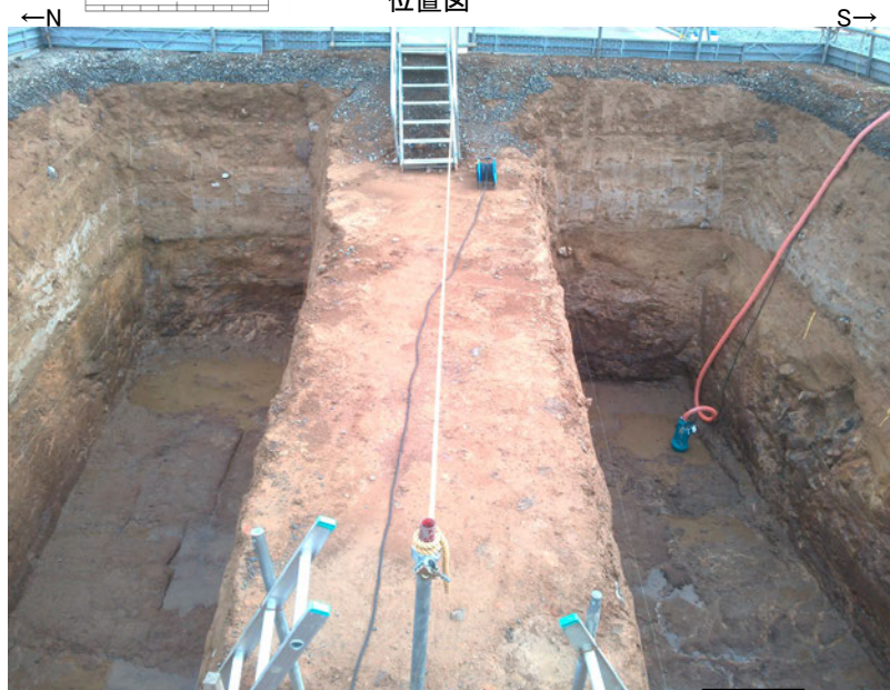
トレンチ状況写真(西側から撮影)
