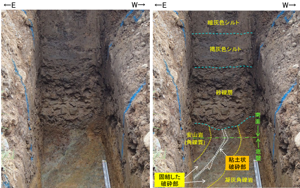
南面 拡大写真
