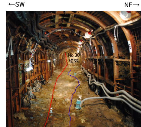
横坑の状況写真 (立坑側より, 2013年撮影)
