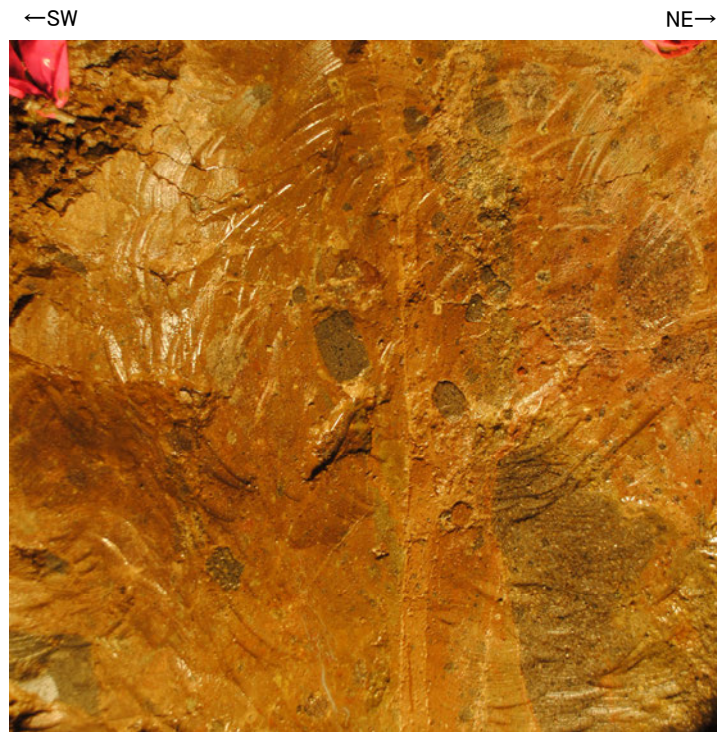
No.15付近底盤写真
