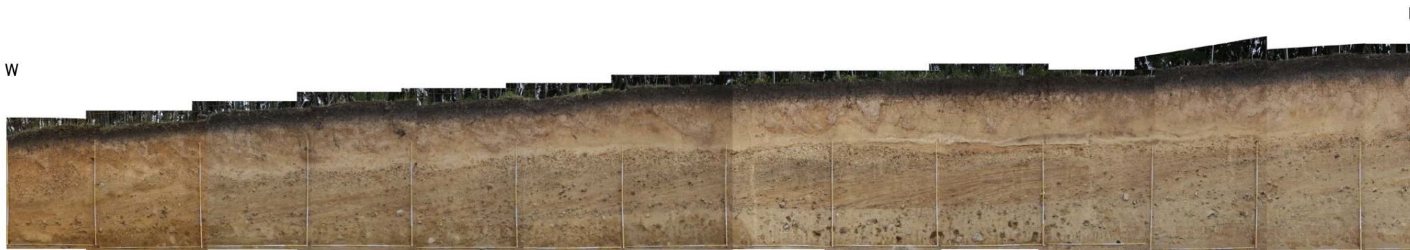
法面④ 写真
