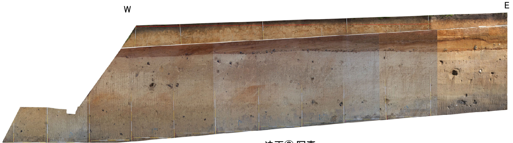
法面② 写真
