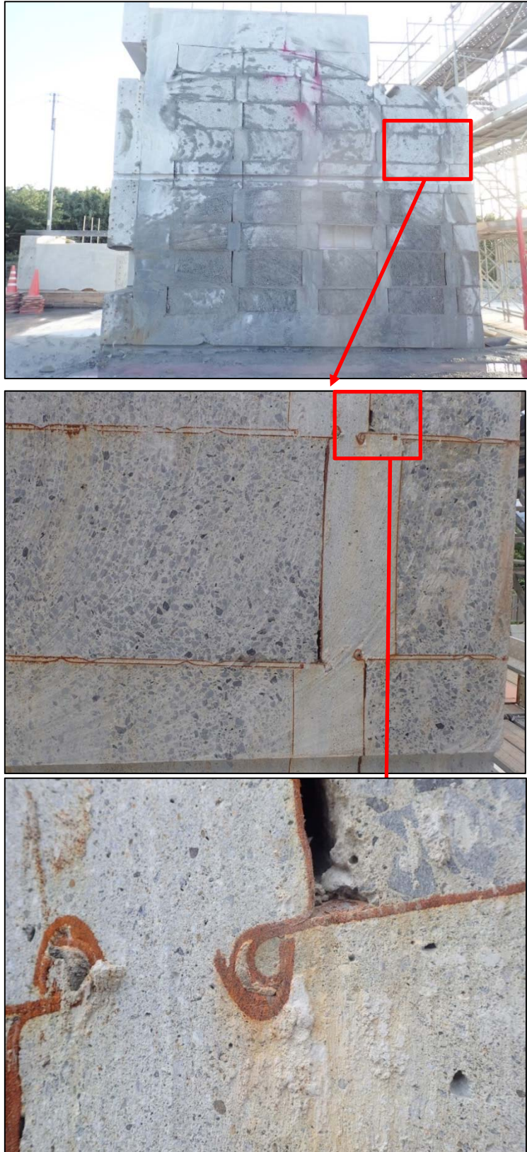
第 33 図 充填状況（側面）
