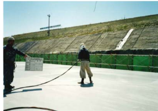
防水材吹付け
