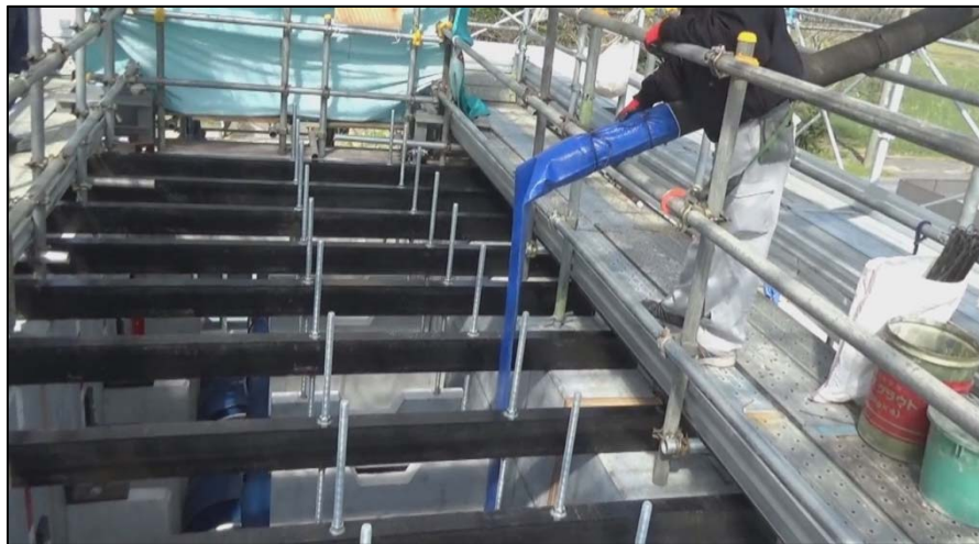
第 25 図 充填モルタル打込み状況
