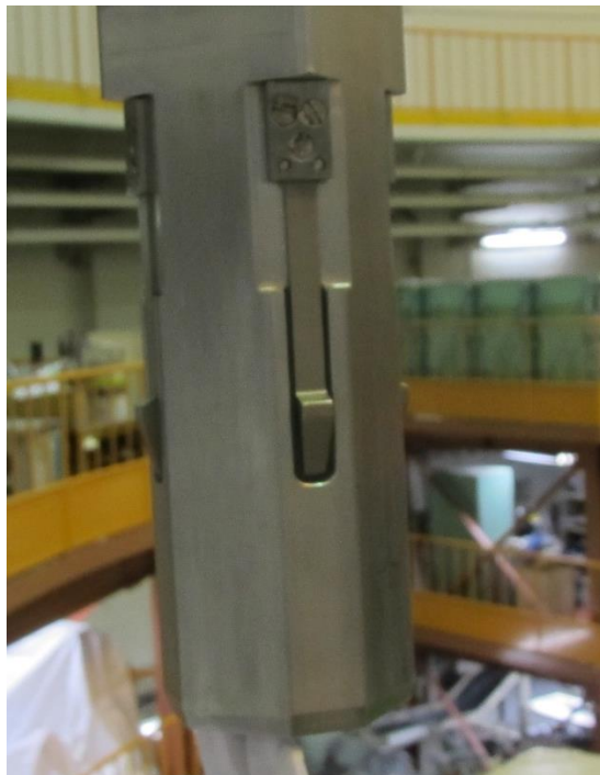
制御棒案内管プラグ部及びバネ (H23 の制御棒案内管交換時撮影)
