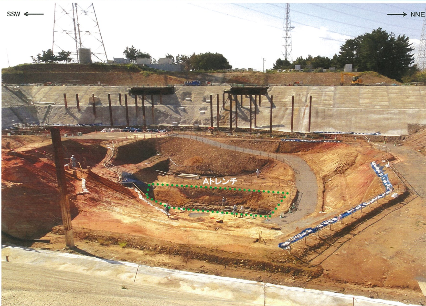
トレンチ調査位置 遠景写真
