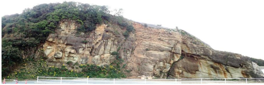
開削面露頭全景 (2019年11月6日撮影)
