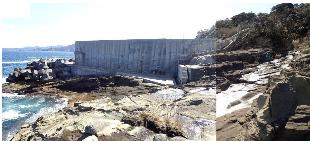
図2-41 防波壁（西端部）地山状況
