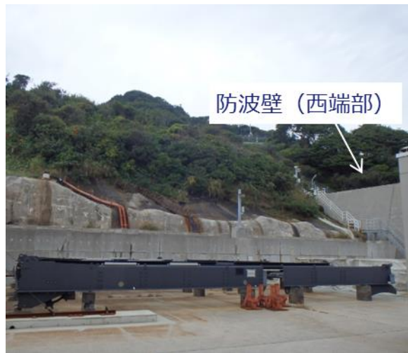
図 2 - 21 防波壁西端部 状況写真
