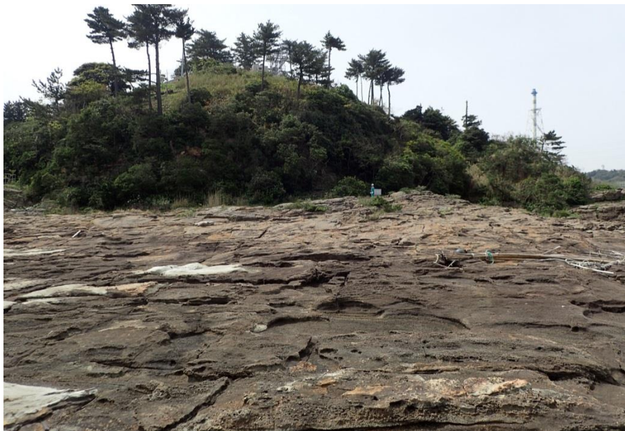
図2-8 (16) 防波壁(東端部)露頭状況 P16 地山北端部 堅硬な火山礫凝灰岩が広く露出する。
