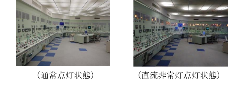
図 2.5-4 直流非常灯照明下での中央制御室のイメージ (シミュレータの点灯例)
