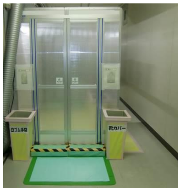
図 3.3-6 チェンジングエリアの外観
