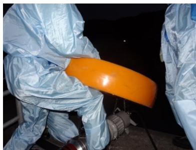
水中ポンプ設置準備（夜間）
