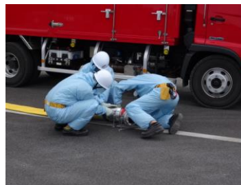
ホース接続作業（昼間）
