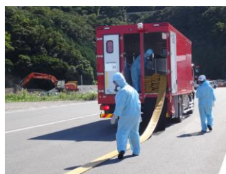
ホース展張作業（昼間）
