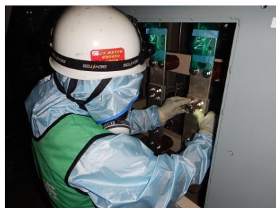
ボルトリンク接続作業
