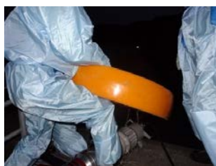
水中ポンプ設置準備（夜間）
