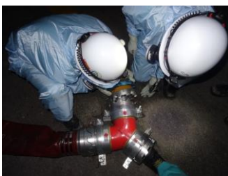
ホース接続作業（夜間）
