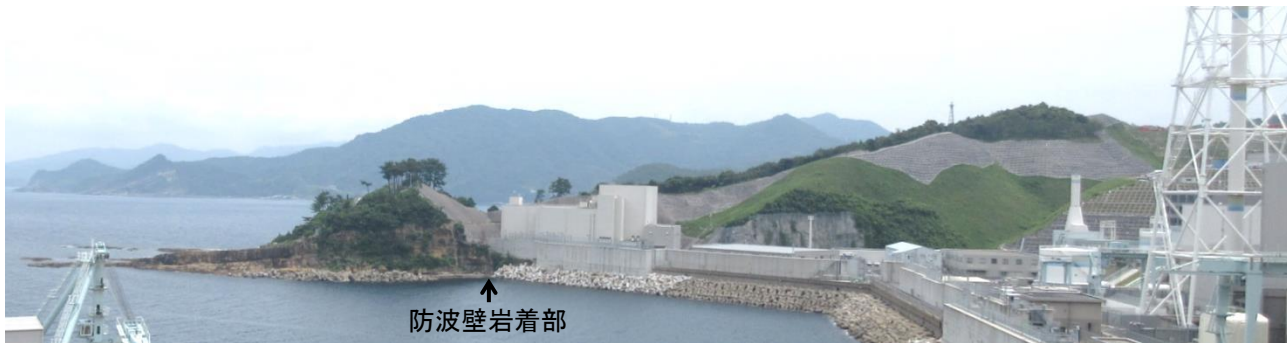
P1 防波壁（東端部）全景 岩着部は尾根の先端を開削した法面に位置する。
