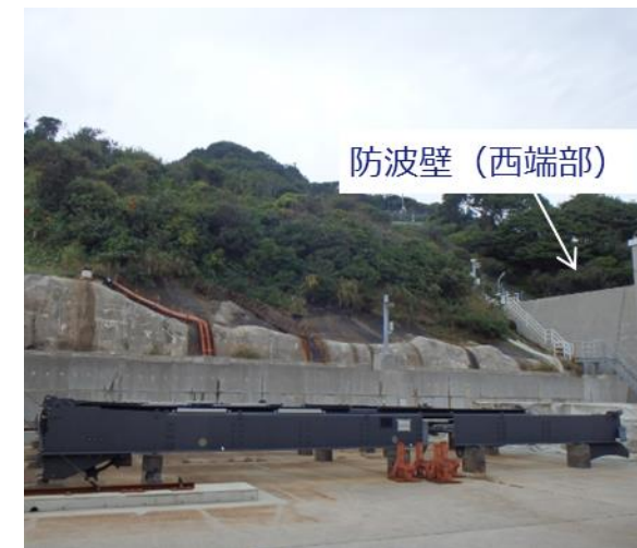
図2-21 防波壁西端部 状況写真
