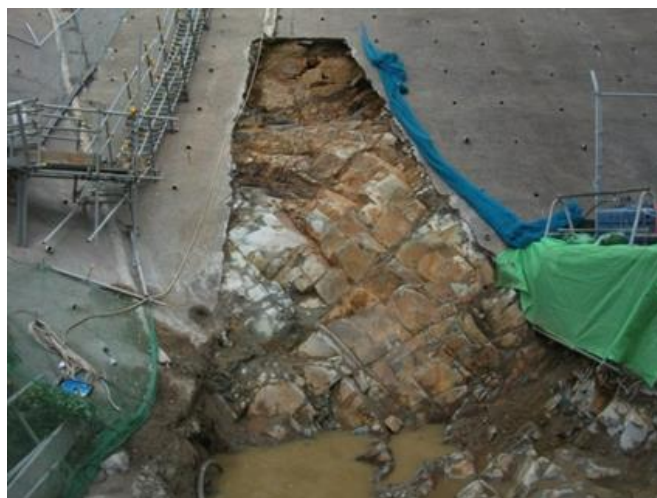
図 2 - 19 防波壁東端部 岩盤露出状況
