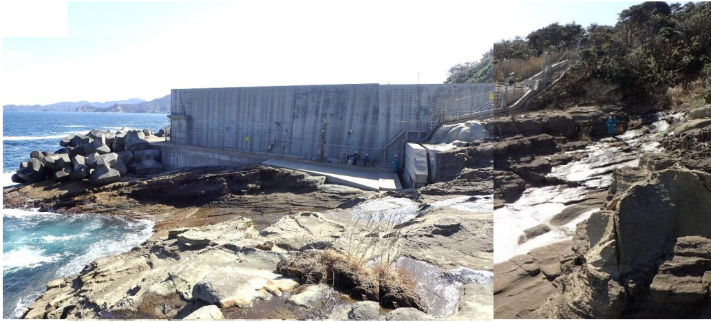
图 2 - 41 防波壁（西端部）地山状况
