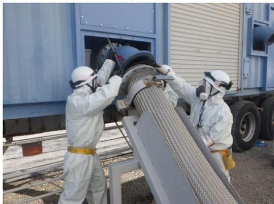
移動式代替熱交換設備
