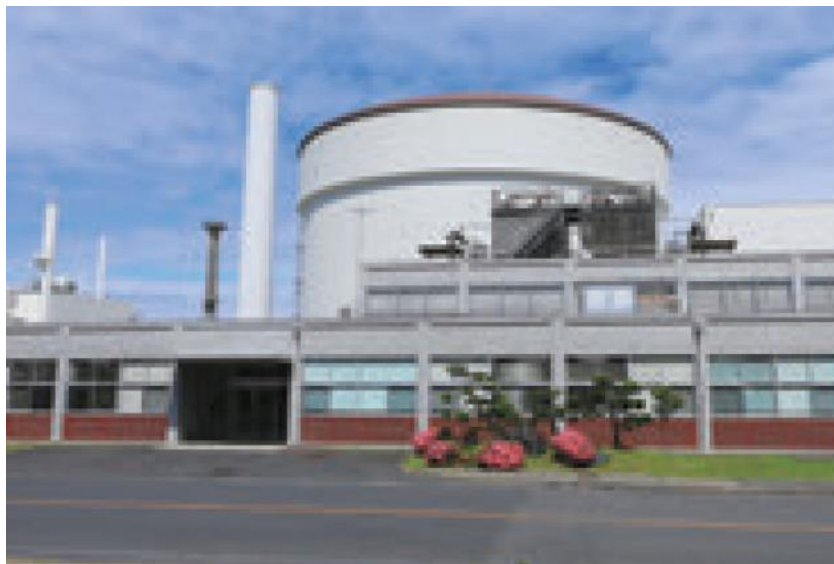
原子炉建家外観(耐震工事前)
