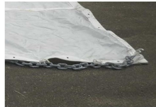
端部拡大写真 (重り (チェーン))
