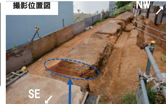
横断掘削箇所③
