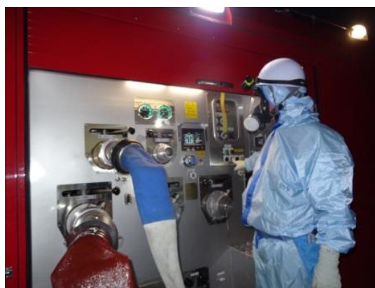
ポンプ起動操作（夜間）
