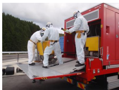
水中ポンプ設置準備
