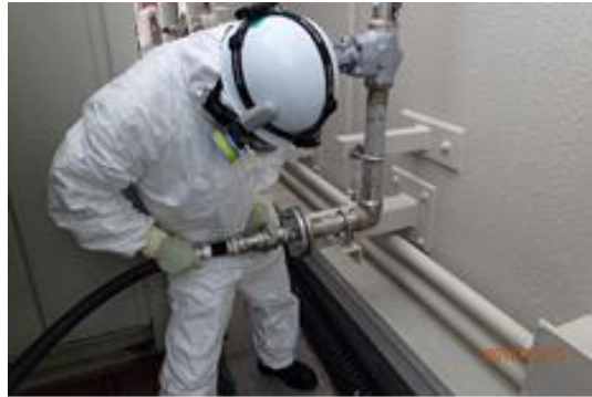
ホース接続作業
