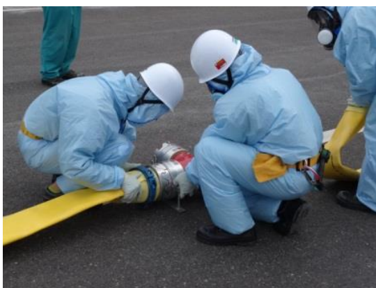
ホース接続作業（昼間）
