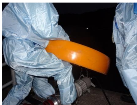
水中ポンプ設置準備（夜間）
