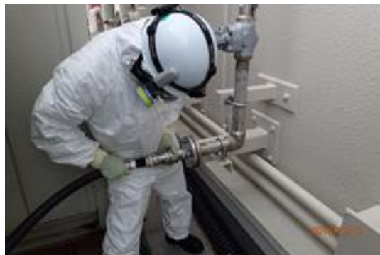
ホース接続作業
