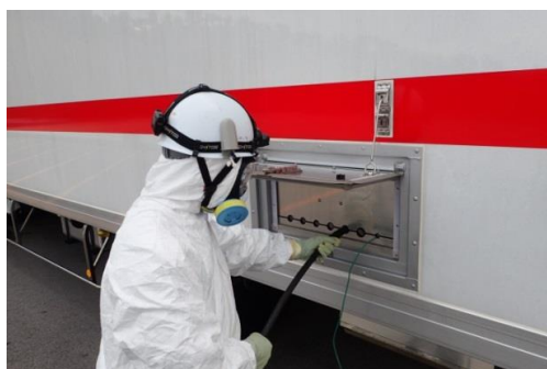
ケーブル接続作業
