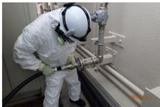
ホース接続作業
