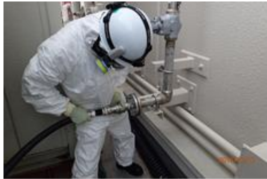
ホース接続作業
