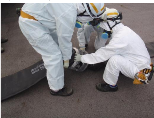
ホース接続作業
