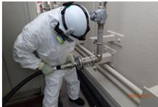
ホース接続作業
