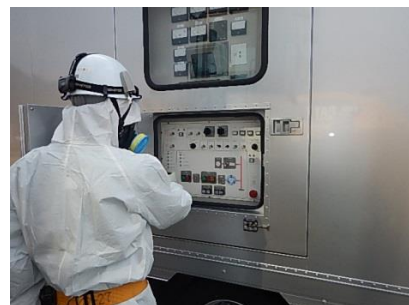
高压発電機車での作業
