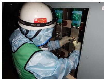
ボルトリンク接続作業
