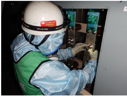
ボルトリンク接続作業
