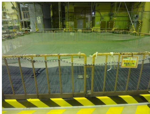
図 2 大物搬入口外観
