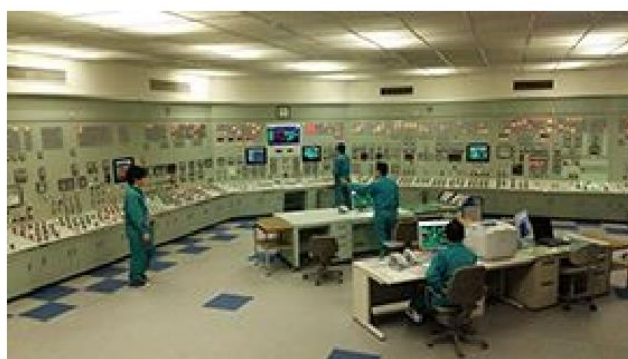
シミュレータを用いた運転操作訓練の状況 （写真は自社施設での実施状況，電源喪失時を想定）
