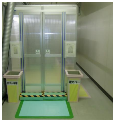
第 6 図 チェンジングエリアの外観
