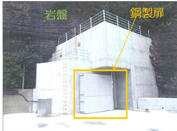
第 1-45 図 防波壁通路防波扉（1号放水連絡通路防波扉）⑤ 設置状況
