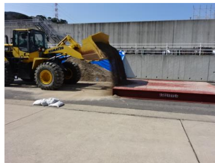
第6図 段差復旧状況
