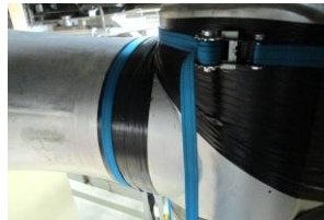
第3図 修復模擬作業状況
